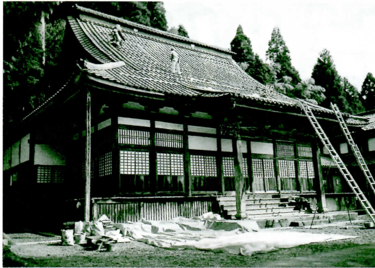
本堂屋根瓦修復工事の様子
