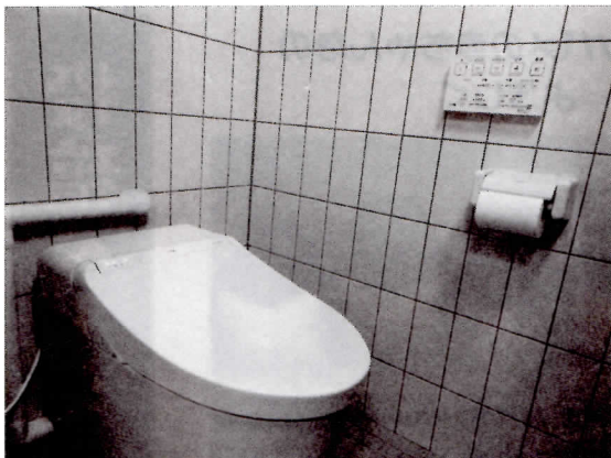
洋式ウォッシュレットに改修されたトイレです!
