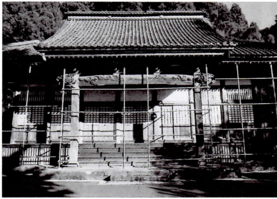
鉄パイプで常設された雪囲い用支柱
