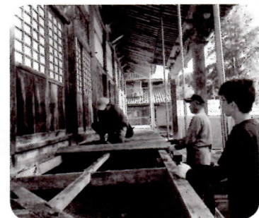
節くれだつた板を取り除いています
